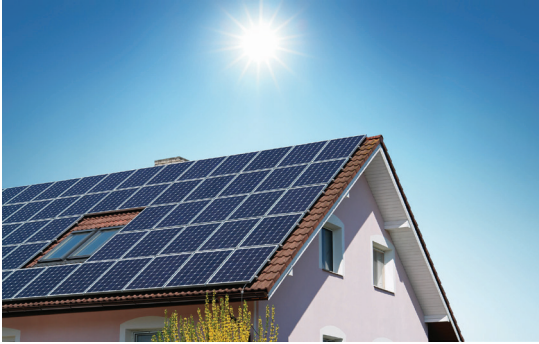
Monitoramento de módulos, Strings e arranjo solar
